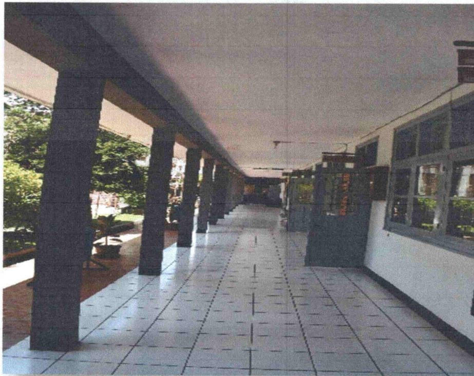
Foto 7. selasar lantai dasar bangunan Gedung Kejari, dimana dibangun menggunakan lantai tegel abu-abu ukuran 20 x 20 cm, namun dalam perkembangannya diganti dengan tegel keramik warna putih ukuran 30 x 30 cm. (Sumber : Dokumentasi TACB Kab. Banyumas )
